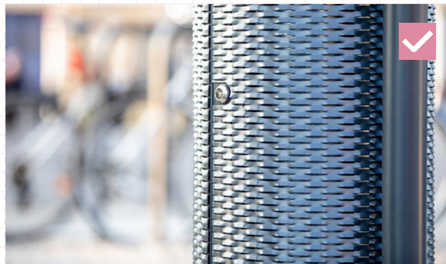
16 Príklad vhodného materiálového a farebného prevedenia z ocele s antracitovou povrchovou úpravou. Osobitnú pozornosť treba dávať na detaily.
