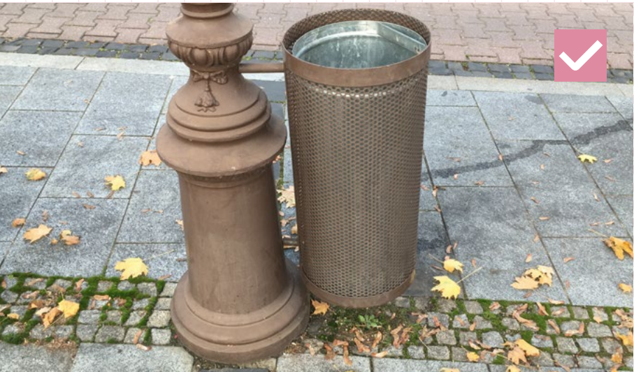
19 Vhodný príklad kotvenia koša do iného prvku mobiliáru.
