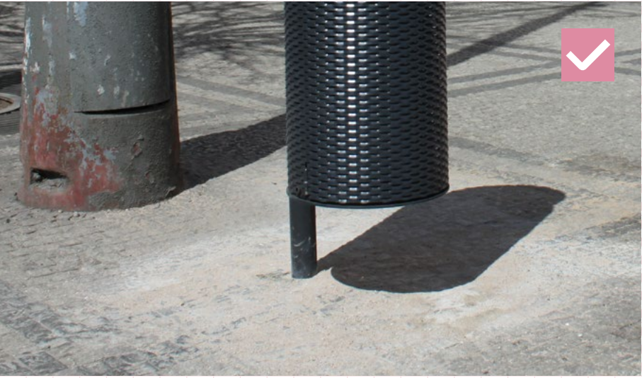
21 Vhodný príklad podpovrchového kotvenia koša na tyči.
